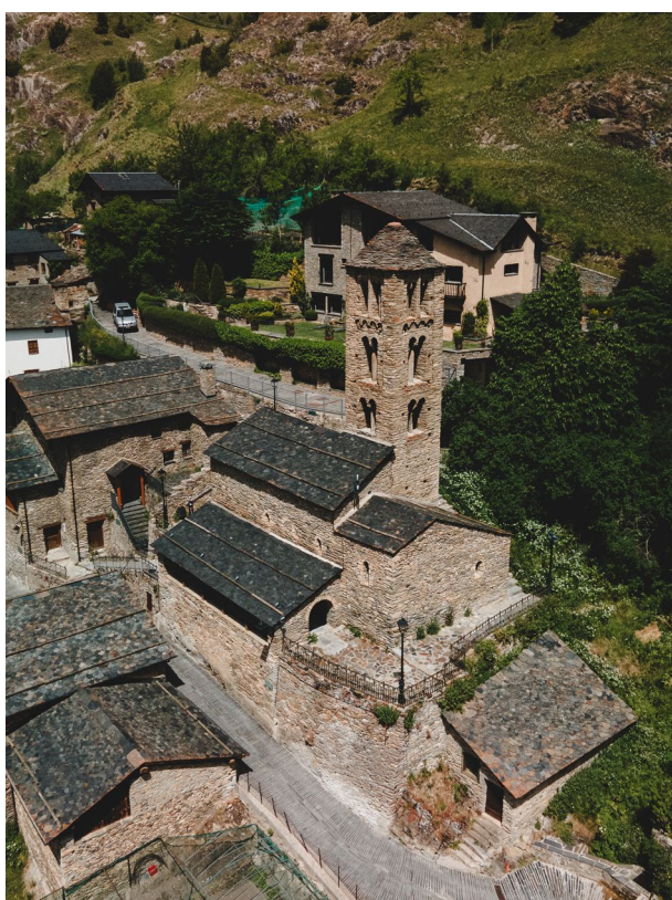
Sant Climent de Pal. Església d'origen romànic i construïda entre els segles XI i XII.
